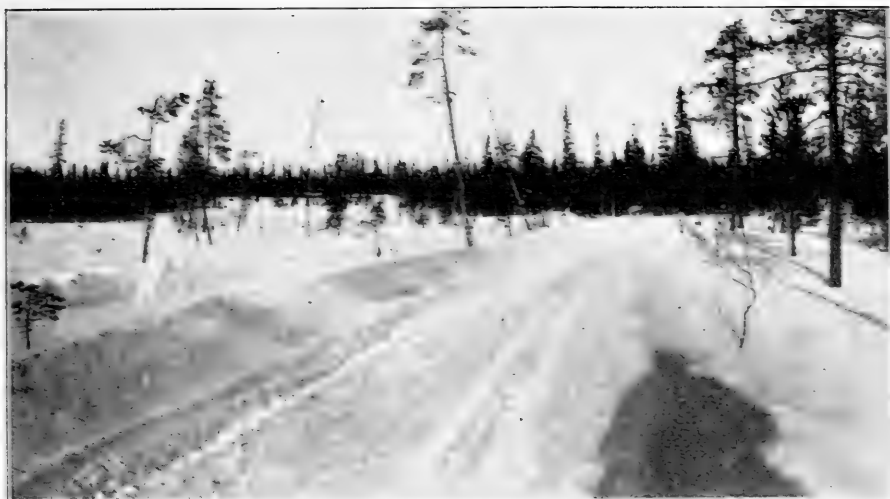
Fig. 2. Basvägen. Till vänster om vägen har parallellt med densamma uppkastats ett dike, vilket uppfångar drevsnön och således hindrar densammas indrivning i vägen.
